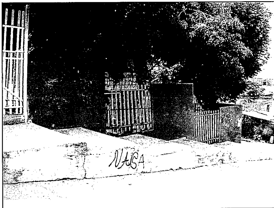
Foto 5.6.5 Construcciones en la parte baja del deslizamiento que muestran las paredes y escalones deformados
