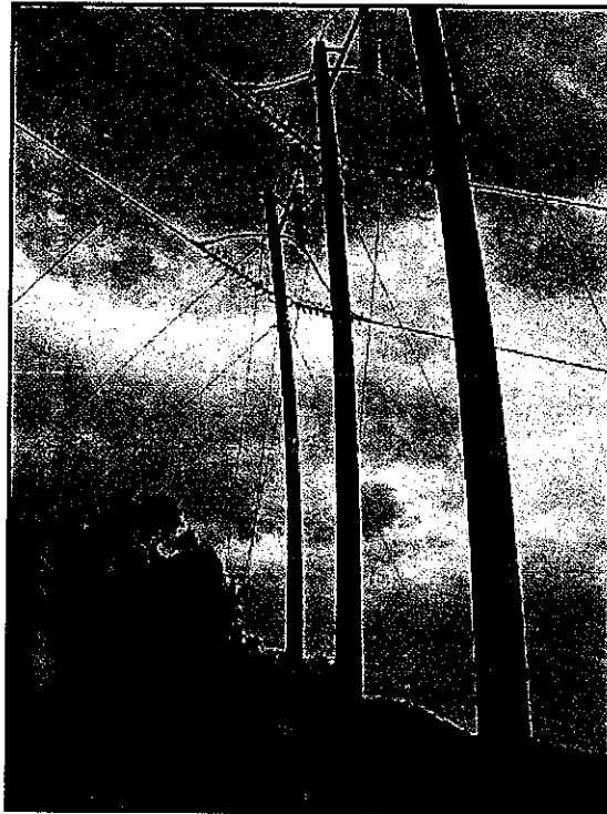
Foto 3.2.50 Postes de alta tensión deformados en zona de acumulación del deslizamiento
