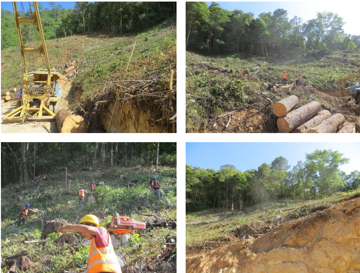
Figura IX—6. Ejemplo de las actividades de desmonte
