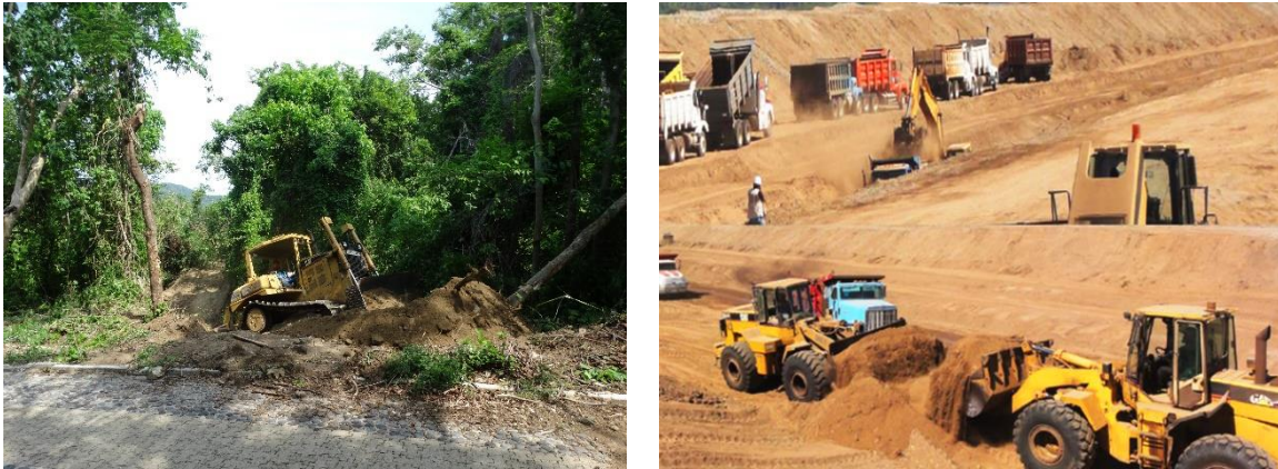
Figura IX—7. Ejemplo de las actividades de despalme
